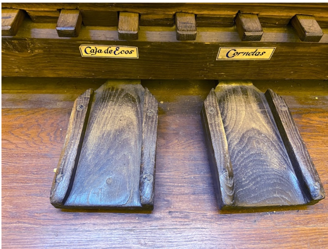
Pisas en corredera para la acción de la corneta en eco
